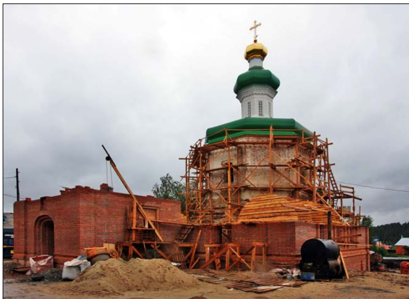
Ил. 20. Начало реставрационных работ на соборе Святой Живоначальной Троицы. 2010 г. Фото: М.Ю. Баранов
